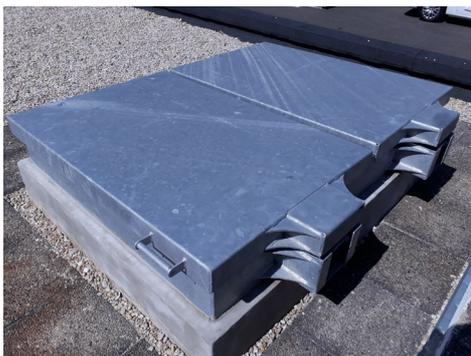
Pour sécuriser l'accès à l'eau contre les risques de malveillance, les réservoirs R1 et R2 de l'usine ont été équipés de capots à double enveloppe cadencés et de grilles de ventilation sécurisées.
